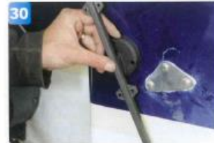
30 Mät ut en lämplig plats för bordsgenomföringen en bit över vattenlinjen.
