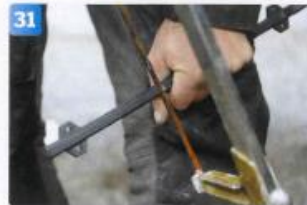
31 Såga av kabelhöljets med en bågfil.
