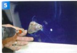
... och hålen täcks över med en täckbricka som skruvas på plats efter att de tidigare hålen täckts igen.
