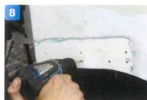
De gamla hålen rensas ur för att det ska bli lättare att sätta igen dem.
