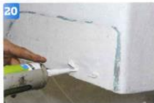
20 Snåla inte med tätningsmassan i hålen.
