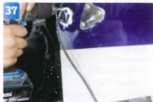
37 Borra hål för fästena till kabelhöljets och skyddslocket till genomföringen.
