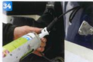
34 På med rikligt med tätningsmassa runt gängor och fläns på genomföringen.
