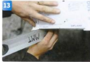
Måtta in bormallen i höjd- och sidled. Mallen har "fötter" så att man kan stöda den mot till exempel ett vattenpass som läggs parallellt med botten.
