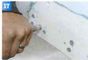
Fräs ur hålen ett par millimeter så att tätningsmassan får plats att bilda en "packning" runt skruvhålen.
