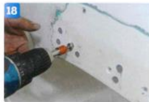
Skruva sedan in och ut skruvarna utan att dra åt för att förgånga borrhålen, då känner du om du drar lagom hårt när interceptorena ska dras på plats.
