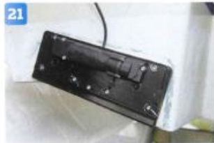
21 Även hålen på interceptorn ska fyllas med tätningsmassan innan den dras på plats.
