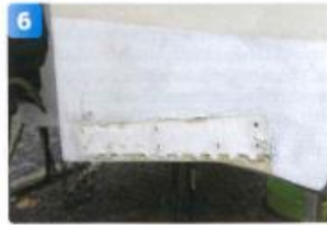
Platsen för interceptorena märks upp med hjälp av mallen som medföljer. På den här båten ryms en av de kortare interceptorena på 300 mm.
