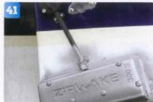
41 De rörliga delarna är monterade och klara. Nu återstår att montera den elektriska delen.
